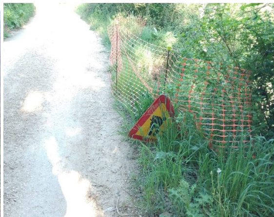
Imatge 5. Vista des de Via amb talús protegit
