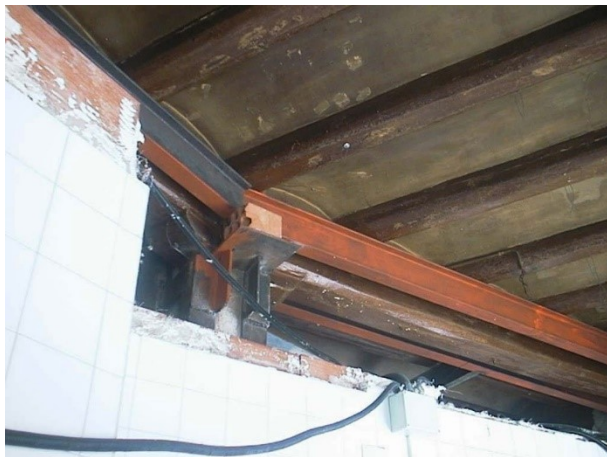
Imatge reforç estructural amb bigues metàl·liques
