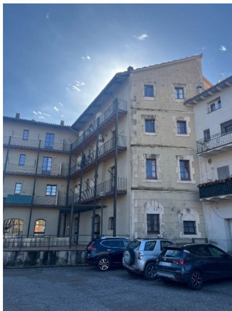
Façana Posterior, estat actual, Num 9, façana a la plaça, vista des del carrer Sant Boi
