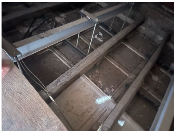
Imatge forjat de coberta amb reforç estructural amb bigues metàl·liques
