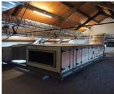
Figura 51. Climatitzador de golfes 1.
