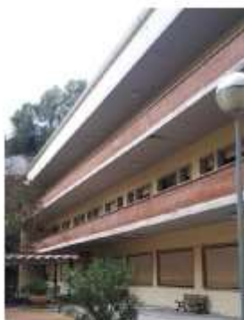
Figura 36. Detall de la façana sud-oest del bloc B del Pavelló Nord.
