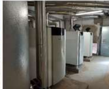
Figura 38. Noves calderes de condensació de Pavelló Nord
