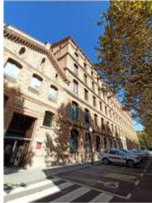
Figura 50. Façana sud-est de l'Edifici del Relotge i annexos.
